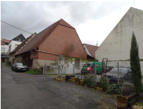
Abb. 9: Südseite der Scheune Lammgasse 15
