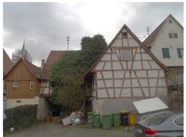
Abb. 12: Nordseite der Gebäude Markstraße 34 mit Holzver- kleidung und Markstraße 36 mit Efeubewuchs
