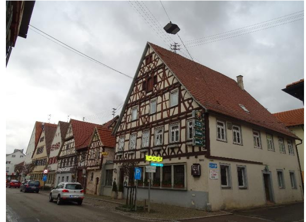
Abb. 14: Südseite der Gebäude Marktstraße 32, 34 und 36
