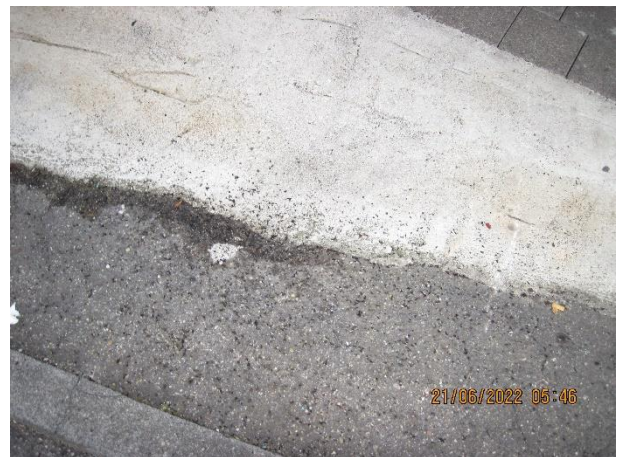
Abb. 27: Kotansammlung unter den Fensterklappläden
