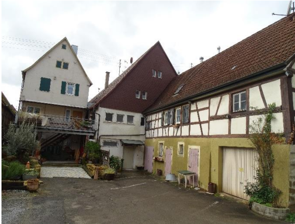
Abb. 13: Nordseite der Gebäude Marktstraße 38 und 40 mit Scheune
