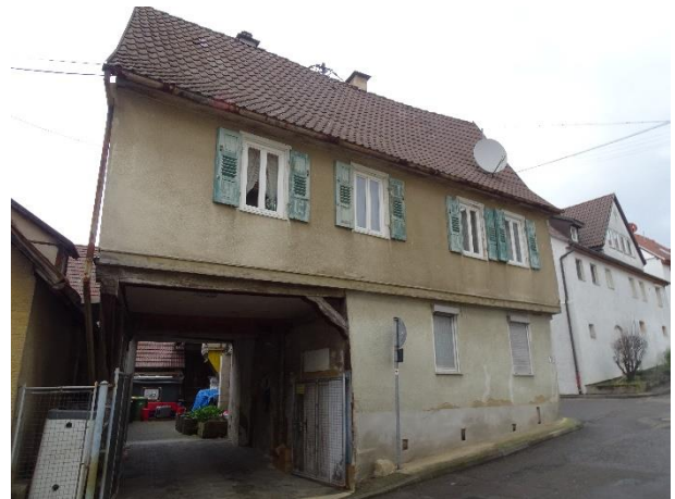
Abb. 4: Ostseite und Durchgang zur Scheune vom Gebäude Pfarrstraße 16
