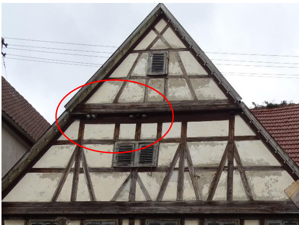
Abb. 18: Vier Schwalbennisthilfen auf der Südseite von Marktstraße 36
