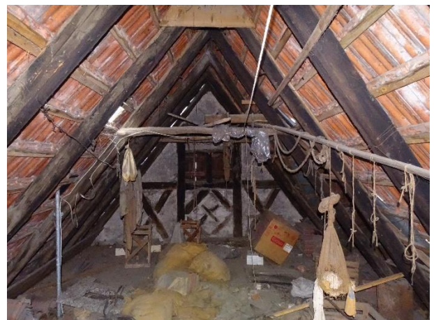
Abb. 19: Dachboden des Wohngebäudes Lammgasse 15
