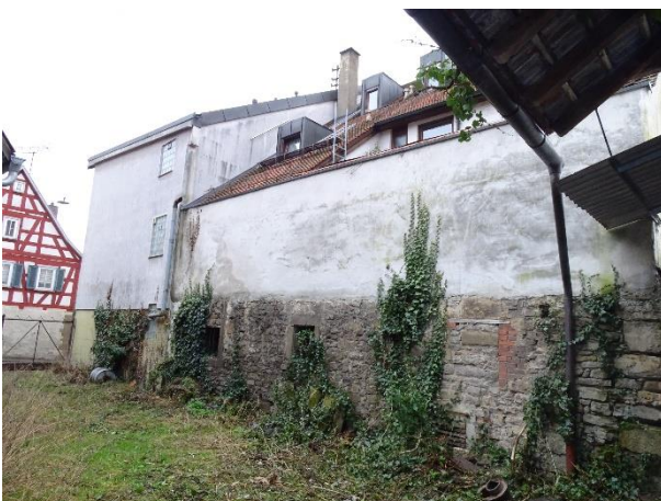
Abb. 24: Nordseite von Lammgasse 3 mit mehreren bodennahen Fenstern
