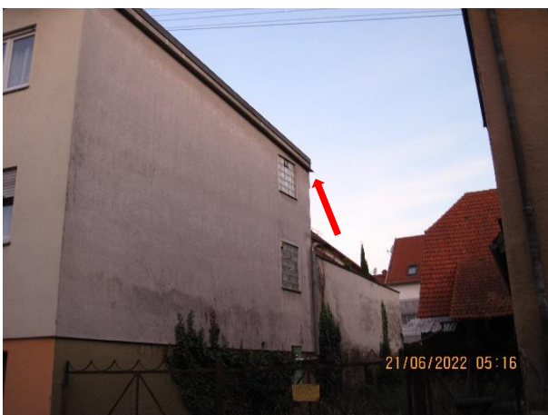
Abb. 28: Einflug einzelner Zwergfledermäuse am Attikablech von Lammgasse 3 (roter Pfeil)
