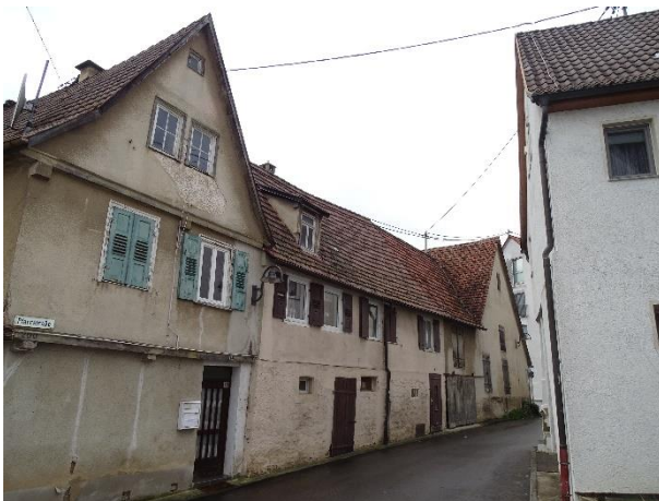
Abb. 3: Nordseite der Gebäude Pfarrstraße 14 und 16
