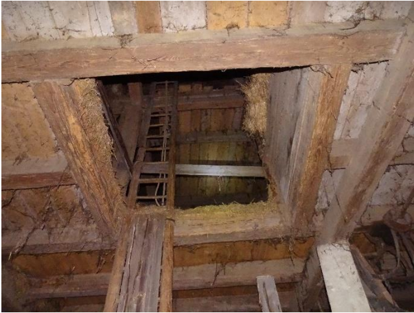
Abb. 20: Blick zu den unzugänglichen Zwischenböden der Scheune Lammgasse 15
