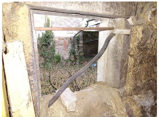
Abb. 23: Fenster mit Spalt im Rahmen der Stallung Lammgasse 15
