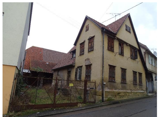
Abb. 6: Leerstehendes Gebäude Lammgasse 15
