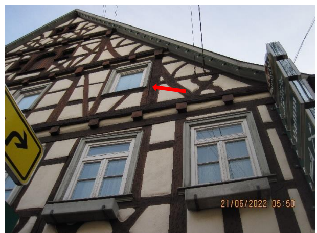
Abb. 29: Einflug einer Zwergfledermaus in eine Spalte auf der Südseite von Marktstraße 32
