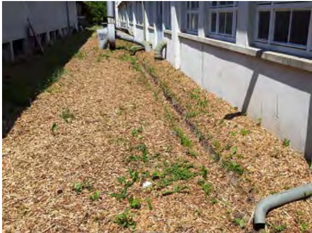
Abb. 5: Grundstücksgrenze im Westen Flste. Nrn. 1824/1 bzw. 1827 Gemarkung Steinheim an der Murr Blick von Süden (Mai 2020)
