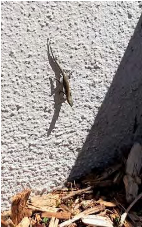
Abb. 11: Juvenile Mauereidechse an der Fassade
