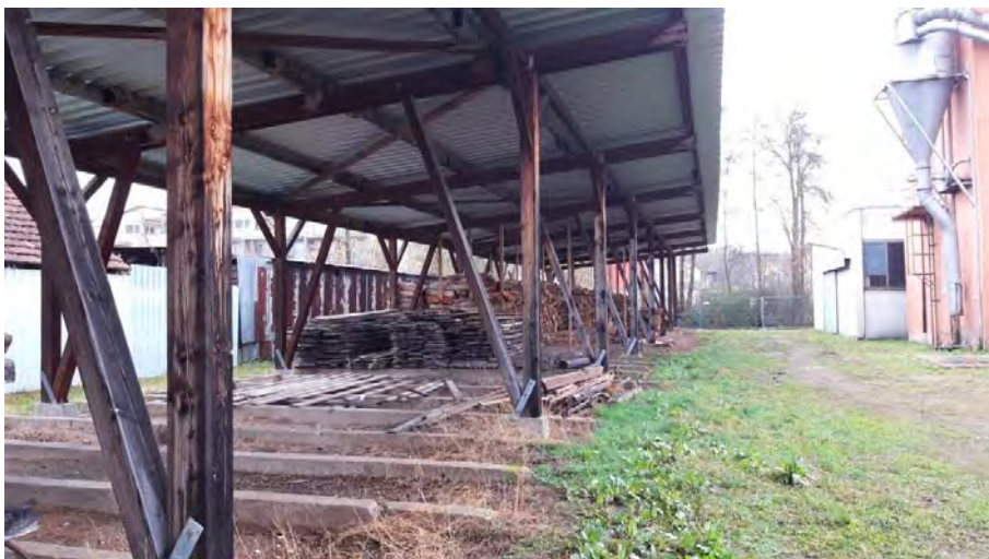
Abb. 3: Das Holzlager im Februar 2020
