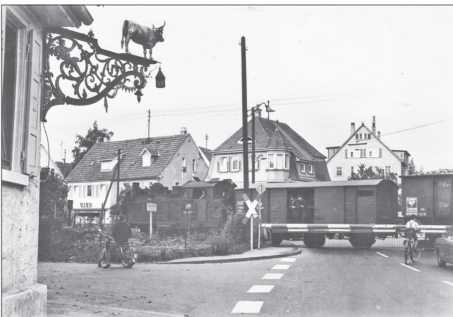
Der Zuckerrübenzug fährt 1967 in den Bahnhof Steinheim ein. Der Verkehr wird durch Bahnschranken geregelt.
