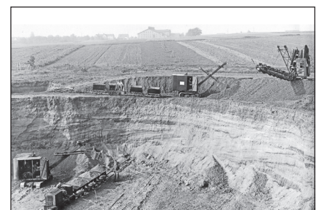
Die Kiesgrube Sammet mit Bagger- und Feldbahneinsatz, 1950.
