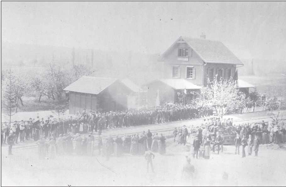
Warten auf den Eröffnungszug am 9. Mai 1894 am Bahnhof Steinheim.
