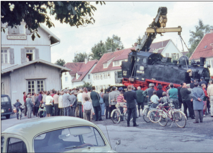
22. August 1969: Die letzte Schmalspurdampflokomotive wird mittels Eisenbahnkran auf ihren Sockel vor dem Bahnhof gehievt. (Foto: Gerald Gunzenhäuser)
